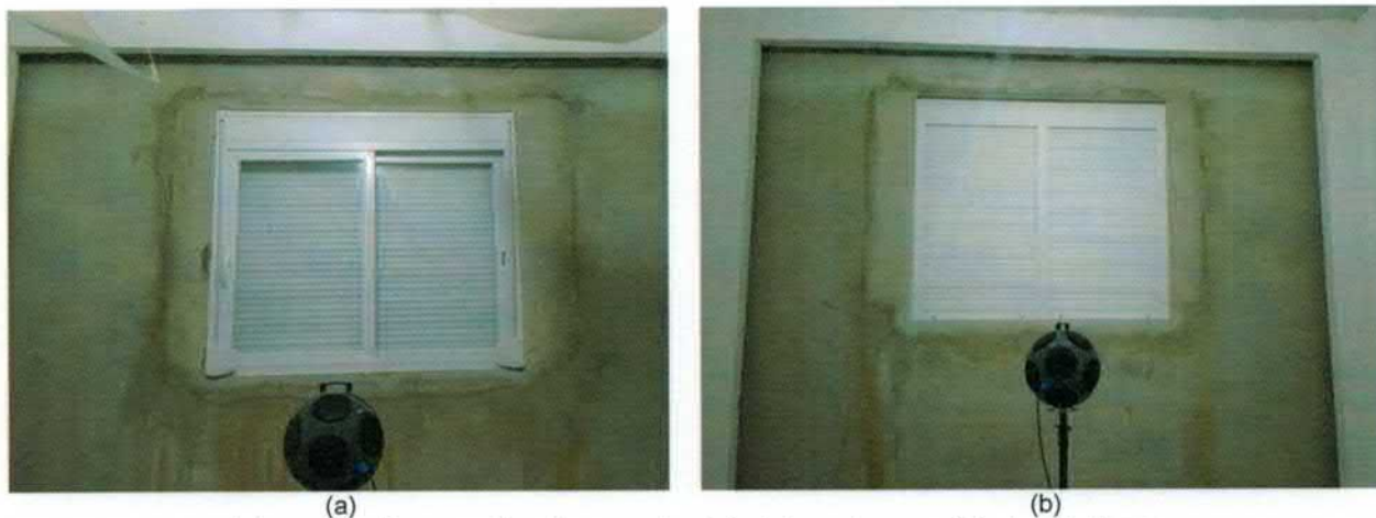
Figura 1 – Perspectiva da amostra (a) vista externa e (b) vista interna
