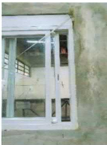
Fixação intermediária da esquadria com espuma expansiva
