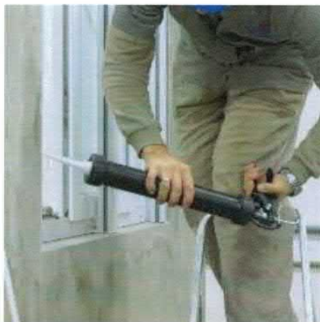
Colocação do silicone branco
