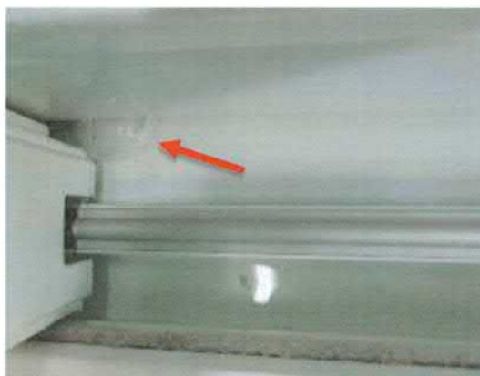
Figura 9 – Ocorrência de Permeabilidade Inicial por ocorrência de bolha com 190 Pa
