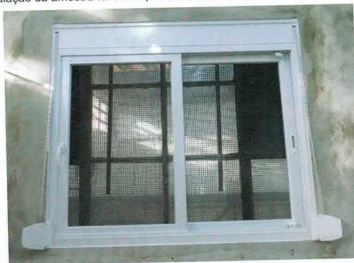
Figura 3 – Instalação da esquadria
