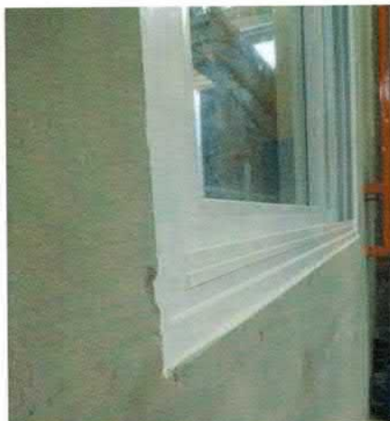
Figura 4 – Instalação da esquadria
