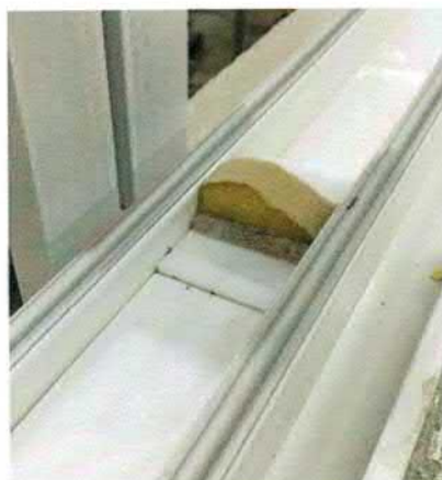
Figura 2 – Descrição do montante com vedação dupla
