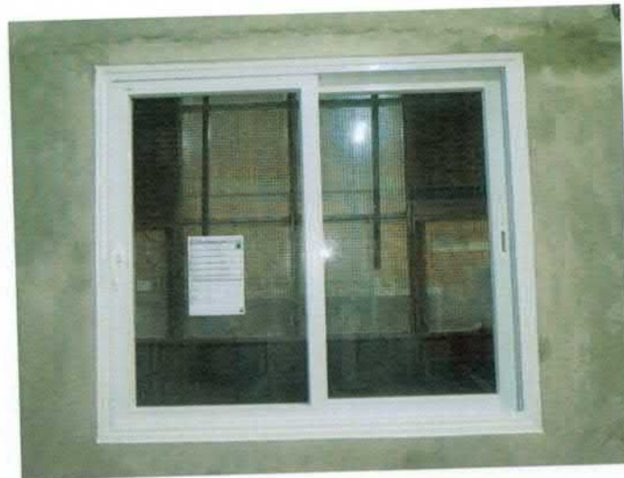
Figura 1 – Esquadria instalada no pórtico
