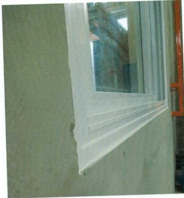
Figura 4 – Instalação da esquadria
