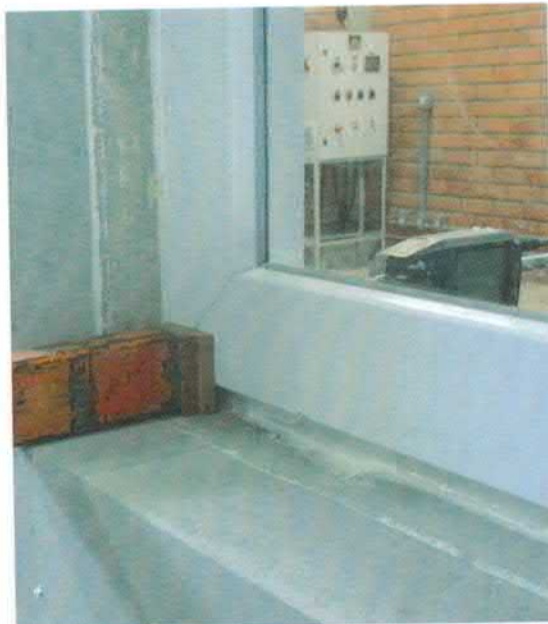
Figura 3 – Instalação da esquadria
