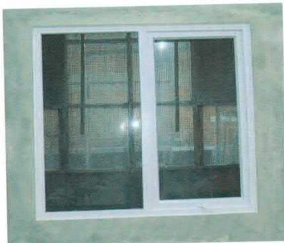
Figura 1 – Esquadria instalada no SVVE
