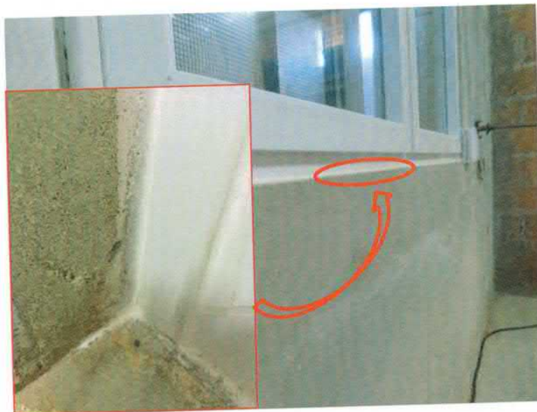
Figura 3 – Instalação da esquadria
