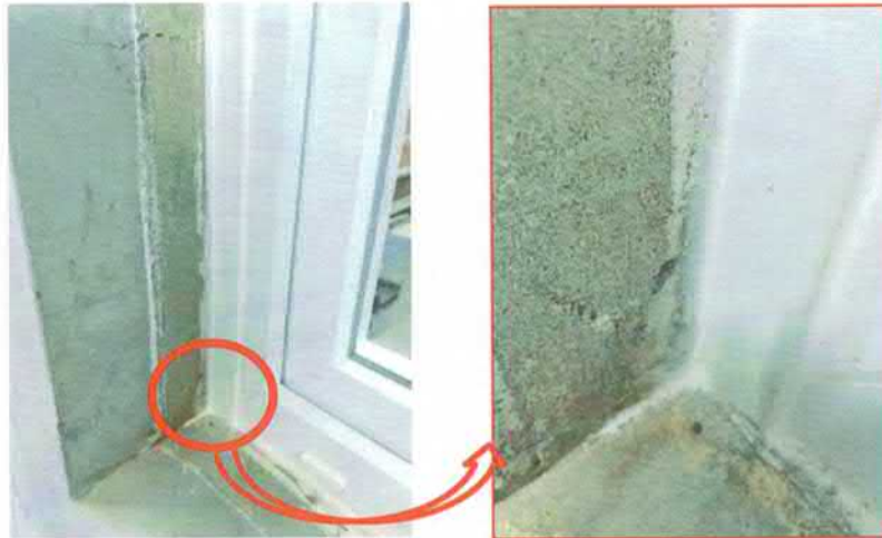
Figura 3 – Instalação da esquadria
