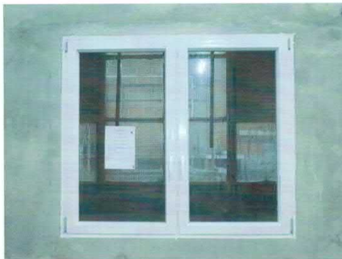
Figura 1 – Esquadria instalada no pórtico
